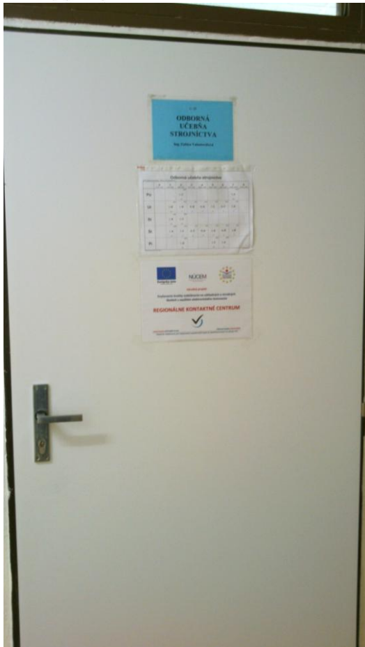
pohľad z chodby
